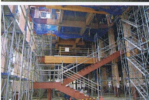
木造住宅を供給する地域ビルダーの本社ビル。鉄骨内蔵型のカラマツ集成材(木質ハイブリッド材)を主要構造部に、国産木材の単板を壁面や床材に用いる。断面欠損を見込めないため外壁面のような限られた箇所に利用されてきた木質ハイブリッド材を、延べ面積6000m<sup>2</sup>を超える規模で内部の柱や梁にまで用いたのが特徴。木質ハイブリッド材の使用量は合計641m<sup>3</sup>に上る(写真・資料:ポラスグループ ポラテック)
