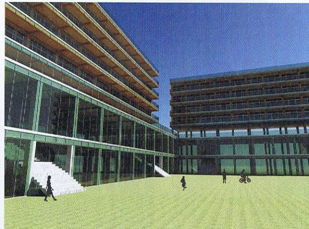
津波避難ビルの提案。下層階はSRC造として津波に備え、上層階は木質ハイブリッド材を用いて、木の美しさを生かす
