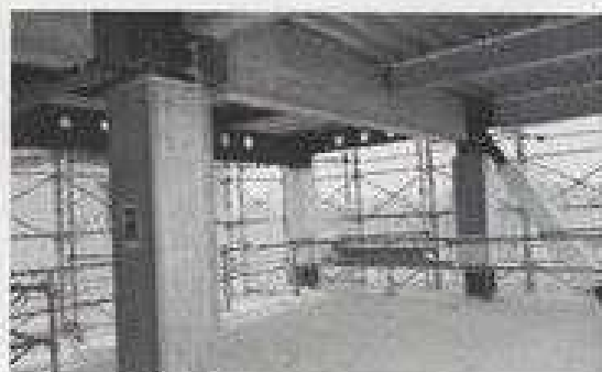
ノンブラケット工法を採用、木質ハイブリッド集成材(鋼材内蔵型)とS造を平面で使い分けられるようになった
